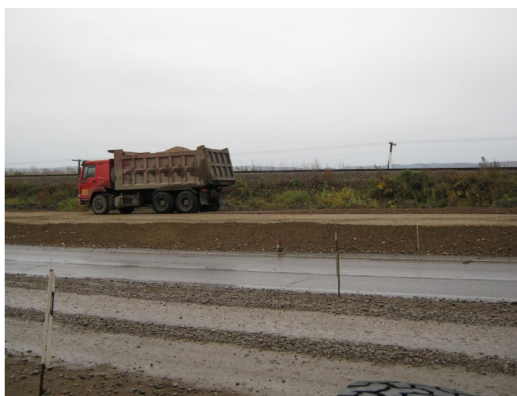
Рис. 1 Выполнение работ на опытных участках автодороги с применением нефелинового шлама и гипсоангидридных отходов
